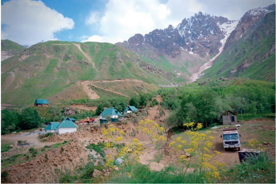
Fig. 22 — Travaux de construction assurés par des ouvriers chinois, Poyi Mazor, district de Vanj.
