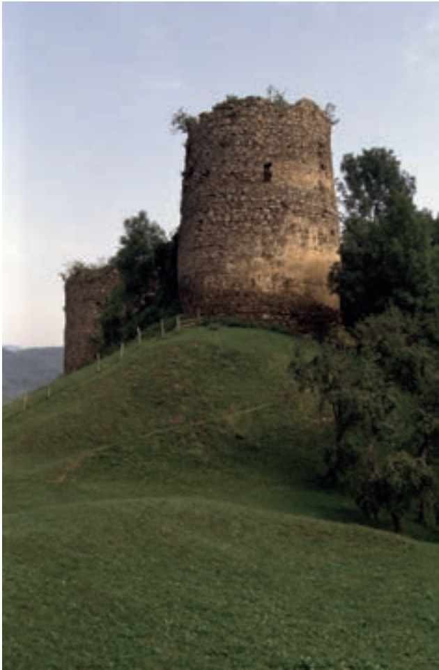
Bild 3: Ruinen von Sebesvár – auch als Burg von Hunyad oder Burg von Kalathaszeg bekannt – mit dem noch vorhandenen Bergfried (Wehrturm), dem Ostrondell und einem Mauerabschnitt. Die nach dem Tatarensturm an diesem strategisch wichtigen Ort errichtete Burg war Jahrhunderte hindurch eine königliche Burg, die am Ende des 15. Jahrhunderts mit einem weit ausgedehnten Herrschaftsgut, das auch einen Großteil von Felszeg umfasste, an die Familie Bánffy verschenkt wurde. Sie galt als sichere Festung. 1598 flüchtete Zsigmond Báthory vor den Türken hierher, und zwei Jahr später wurde auch der in der Schlacht bei Szászfenes (Florești, Sächsisch-Fenisch) verwundete György II. Rákóczi einige Tage in der Burg gepflegt, bevor er nach Großwardein gebracht wurde, wo er anschließend verstarb. Nach dem Freiheitskampf des Ferenc II. Rákóczi ereilte auch die Burg Sebesvár das Schicksal aller ungarischen Festungen: Sie wurde im Auftrag Leopolds I. zerstört. Die Anlage blieb bis in die letzte Zeit vernachlässigt. Seit einigen Jahren veranstaltet das rumänische Dorf Bologa eine Art Dorf- beziehungsweise Trachtenfest im Umfeld der Burg. Foto: Fülemile 1996.
