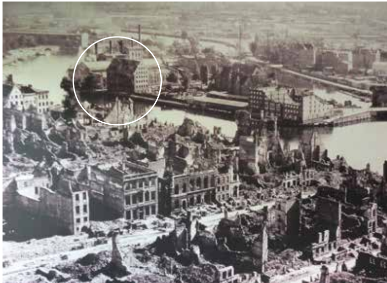
In diesem Gebäude war die Regensburger Archivgruppe untergebracht – hier ist gegenwärtig das Hotel Królewski untergebracht
